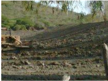
CONSTRUCCIÓN DE BORDOS
