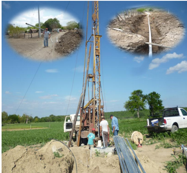
EQUIPAMIENTO DE POZO (TOMA DE AGUA) EJIDO LOPEZ MATEOS E INSTALACIÓN DE TOMAS DOMICILIARIAS EJIDO SAN ANTONIO EL GRANDE
