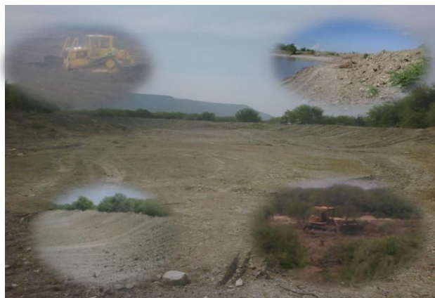
REPARACION DE BORDOS DE PRESAS DE LOS EJIDOS: ESTACIÓN SAN FRANCISCO, LA GLORIA, CINCO DE FEBRERO, PRAXEDIS BALBOA Y LÁZARO CARDENAS.
