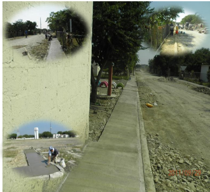
CONSTRUCCIÓN DE GURNICIONES Y BANQUETAS EJIDOS: LÁZARO CÁRDENAS, NUEVO SAN FRANCISCO Y EL AMPARO
